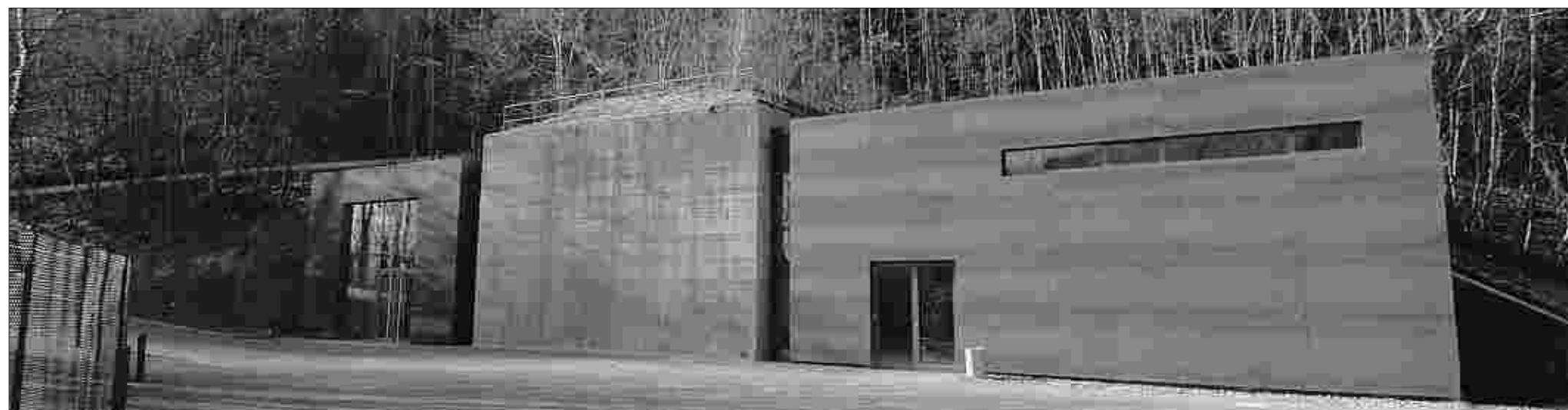
So sieht der Eingang aus: 203 der ehemals mehr als 19 000 Meter Röhre, die den Regierungsbunker beherbergte, bilden heute das Museum, das im März öffnet.
